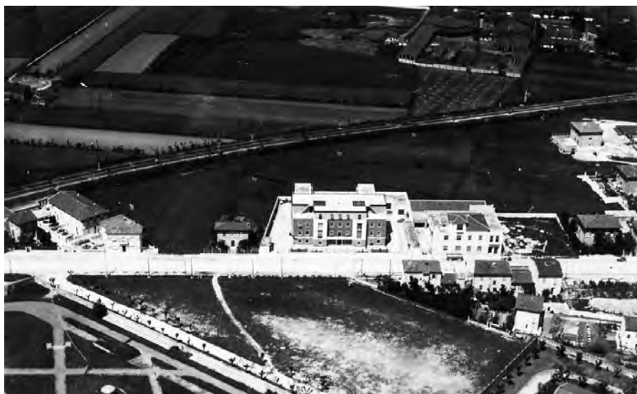
Fondazione della nuova fabbrica di via Bonanno Pisano, Pisa, 1937-1938
